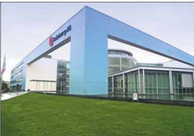
Bild 4. Der Hauptsitz der Salzburg AG, in dem die KNX Straßenbeleuchtungs-Steuerung realisiert wurde.
