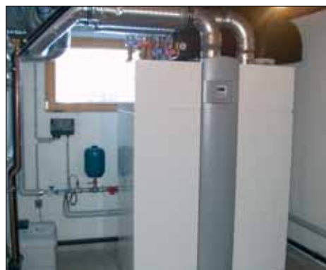
Bild 2. Die Einbindung der Luft/Wasser-Wärmepumpe in die kontrollierte Wohnraumlüftung mittels KNX schafft die Grundlage für sehr günstige Verbrauchsdaten
